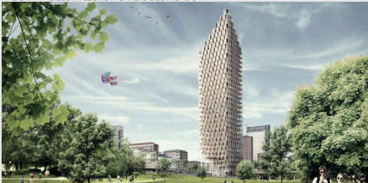
Il merito andrà a Stoccolma, quando nel 2023 sarà ufficialmente completato il più alto edificio con struttura portante in legno mai costruito al mondo. Ecologico, ignifugo ed efficiente, il green building progettato da CF Møller Architects raggiungerà i 34 piani.
