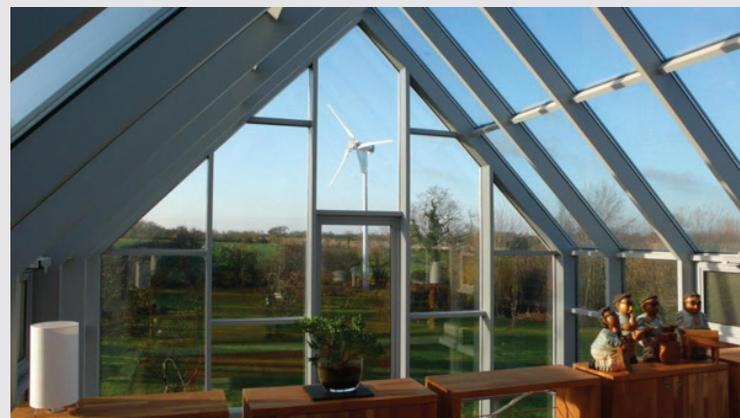
dei proprietari, la copertura inizia a scorrere lungo l'asse longitudinale, modificando completamente l'aspetto e le caratteristiche della casa.
